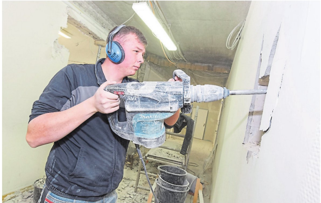
Baustelle Krankenhaus Wittmund: Handwerker Eugen Dell setzt den Bohrer an. Derzeit wird die zentrale Patientenaufnahme erneuert.
